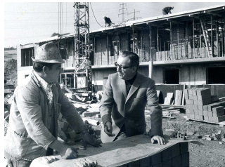
Willy Wegner auf einer Baustelle im Jubiläumsjahr 1972
