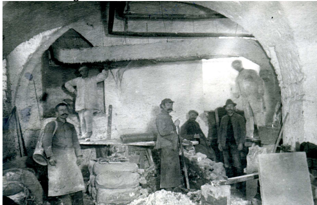
Maurer der Firma Wegner im Einsatz
