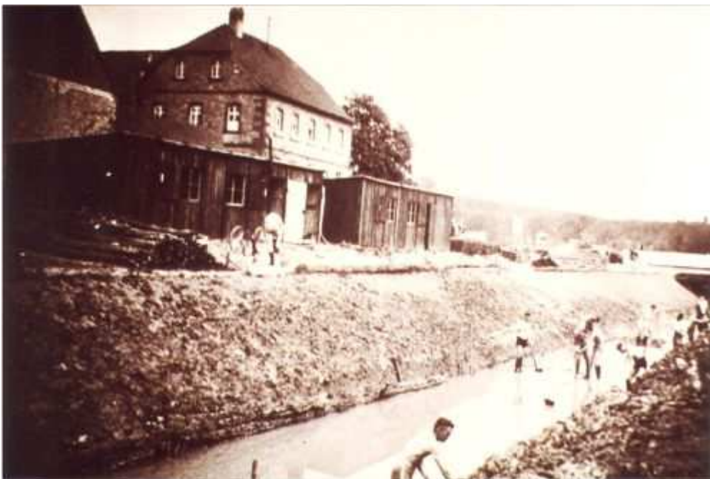
Arbeiten bei Mühlhausen. Rechts im Hintergrund die durch die Regulierung notwendige neue Wernbrücke. (Bildquelle Archiv Markt Werneck)
