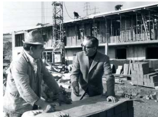
Willy Wegner auf einer Baustelle im Jubiläumsjahr 1972
