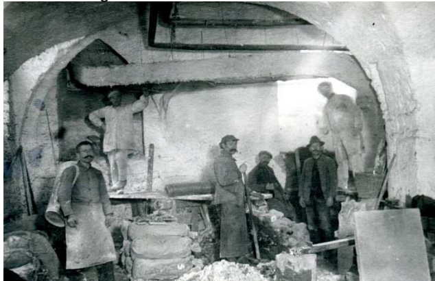
Maurer der Firma Wegner im Einsatz
