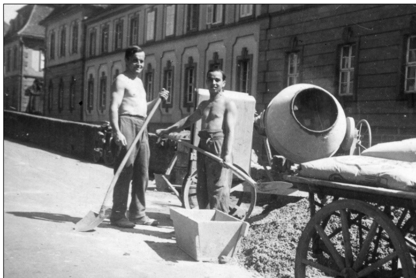
Louis Dony (re.) und ein Kollege beim Arbeitseinsatz an der Wernmauer
