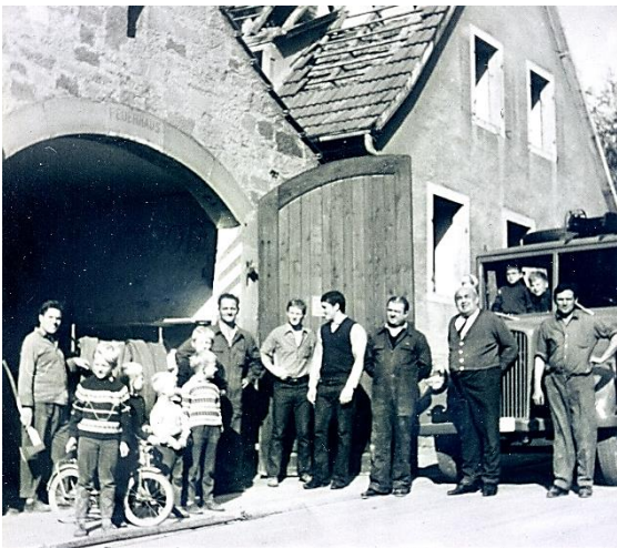
Evtl. ehemalige „Feuerhalle“ in der Spitalstraße
