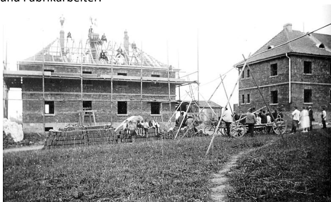
Das Foto zeigt vermutlich die Errichtung der Gebäude 3-5 (Doppelhaus links) und 7-9 (Doppelhaus rechts)
